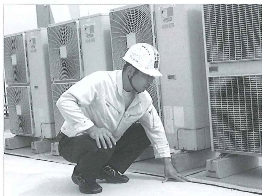
改修工事現場でクーラーの仮置き状況をチェック
